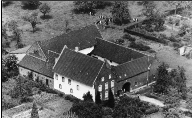
**Abb. 29: Gut Driesch - giebelständiges Haupthaus mit drei Fensterachsen**
