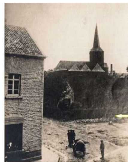
Abb. 2: Baesweiler Wasserpumpe Ecke Roskaul, Kirchstraße. Im Vordergrund das Haus der heutigen Bäckerei Paulussen, Pumpe siehe Pfeil
