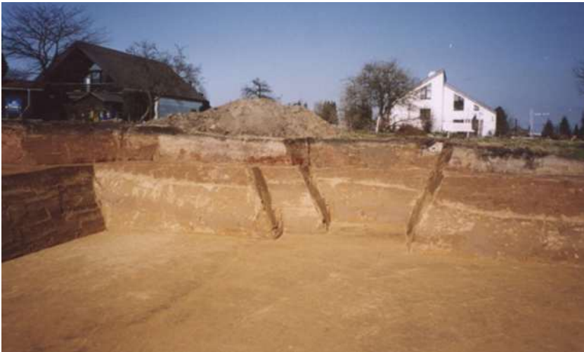
Abb. 1: Blick in die Baugrube für das Haus Baesweiler Roskaul Nr. 38 und 40
